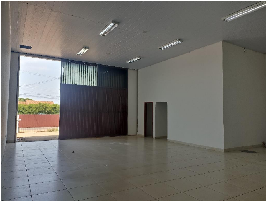
Foto 7. Prédio para Locação em Alta Floresta – Vista interna do imóvel. Foto em 15/11/2023.
