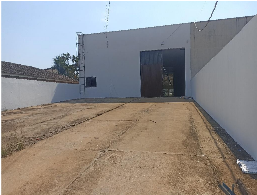
Foto 4. Prédio para Locação em Alta Floresta – Vista do pátio e acesso ao imóvel a partir do portão de acesso frontal da edificação. Foto em 15/11/2023.
