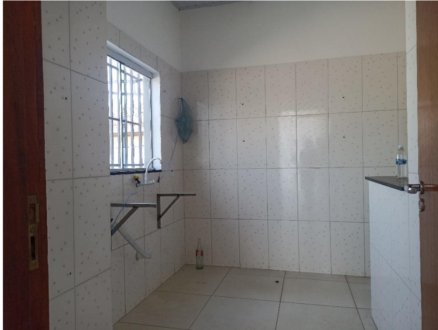
Foto 8. Prédio para Locação em Alta Floresta – Vista da copa a partir da porta de acesso. Foto em 15/11/2023.
