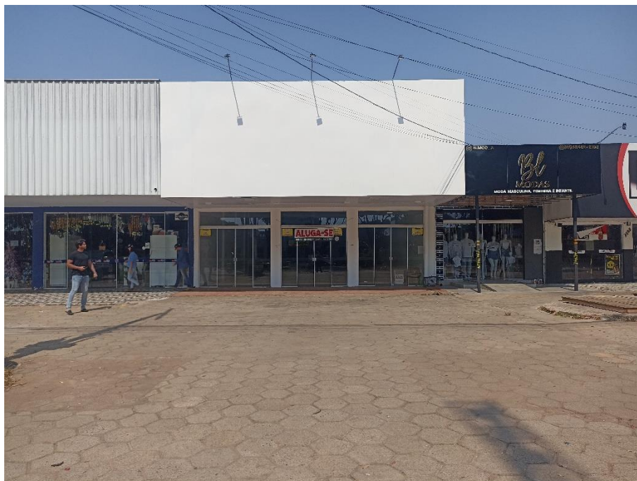
Foto 15. Prédio para Locação em Alta Floresta – Vista da outra extremidade do imóvel. Foto em 15/11/2023.
