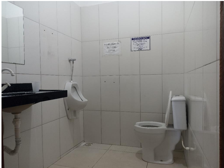
Foto 11. Prédio para Locação em Alta Floresta – Vista do BWC 01 a partir da porta de acesso. Foto em 15/11/2023.
