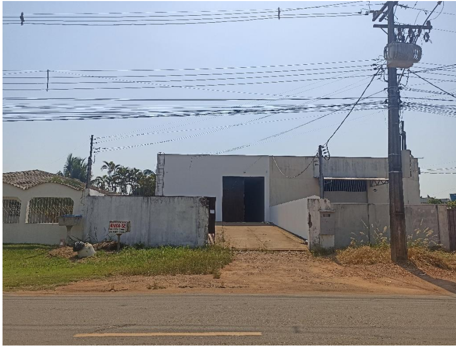
Foto 2. Prédio para Locação em Alta Floresta – Vista da fachada a partir do logradouro. Foto em 15/11/2023.
