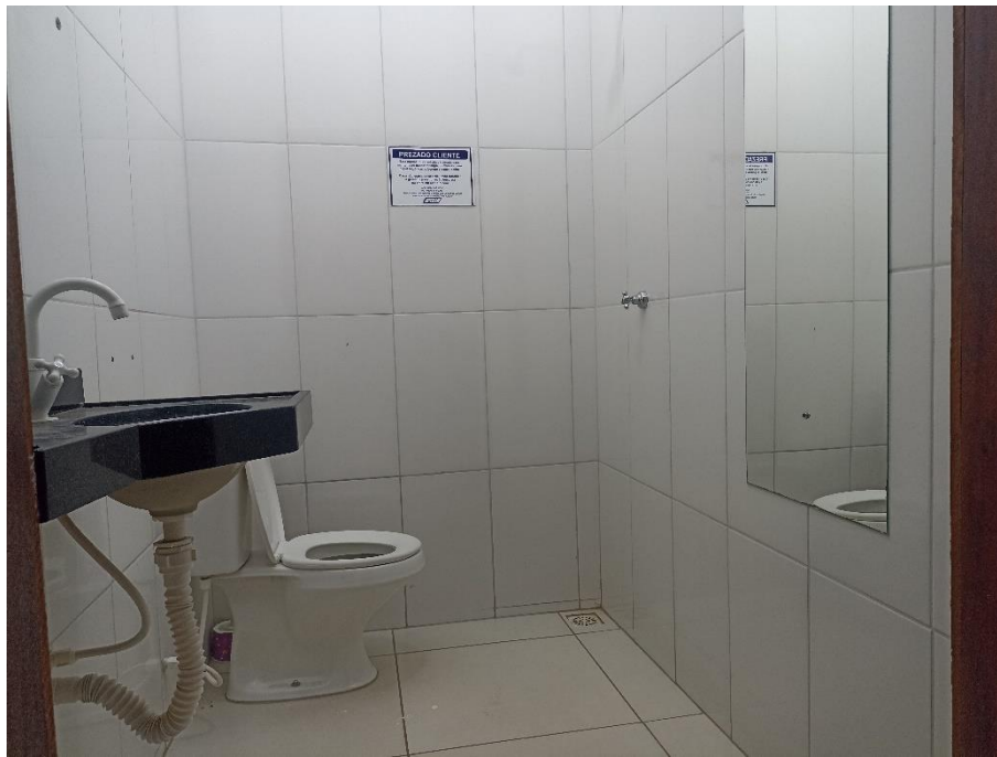
Foto 12. Prédio para Locação em Alta Floresta – Vista do BWC 02 a partir da porta de acesso. Foto em 15/11/2023.
