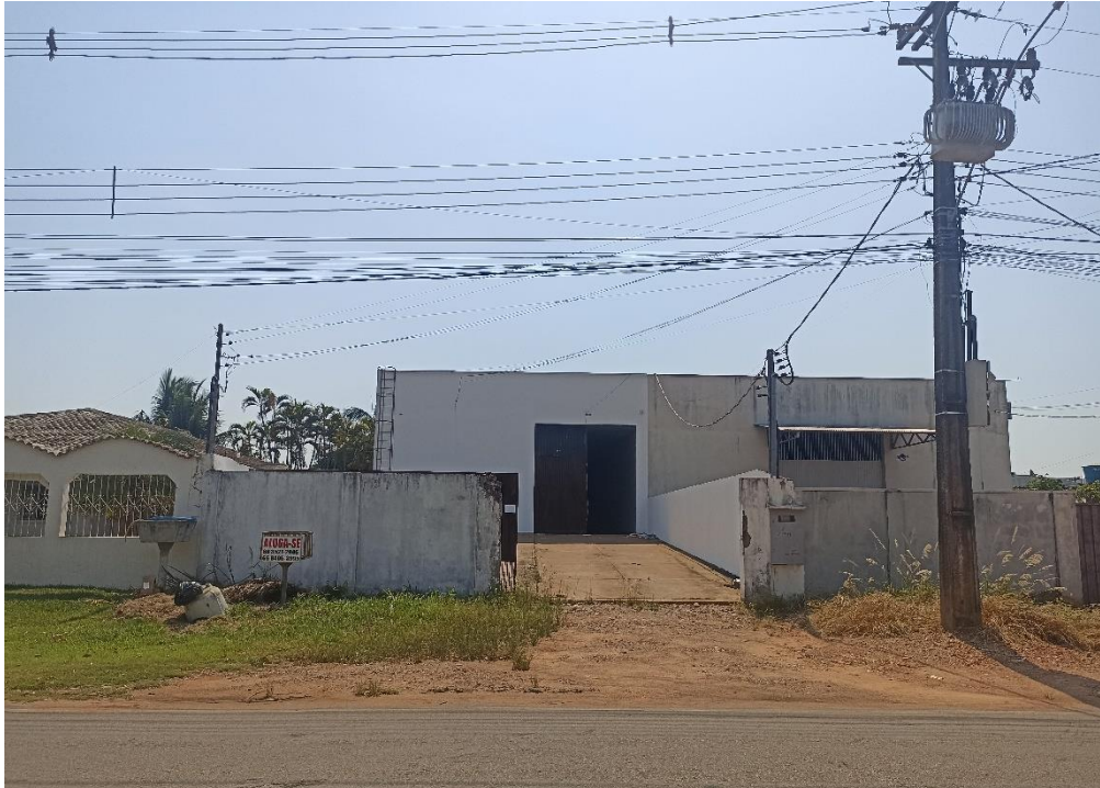
Foto 1. Prédio para Locação em Alta Floresta – Vista frontal da edificação a partir do logradouro. Foto em 15/11/2023.
