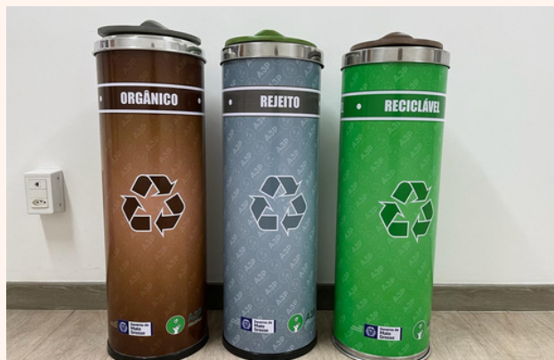
Foto: Instalação de Residuários Coletivos para Coleta Seletiva (CGE/MT)
